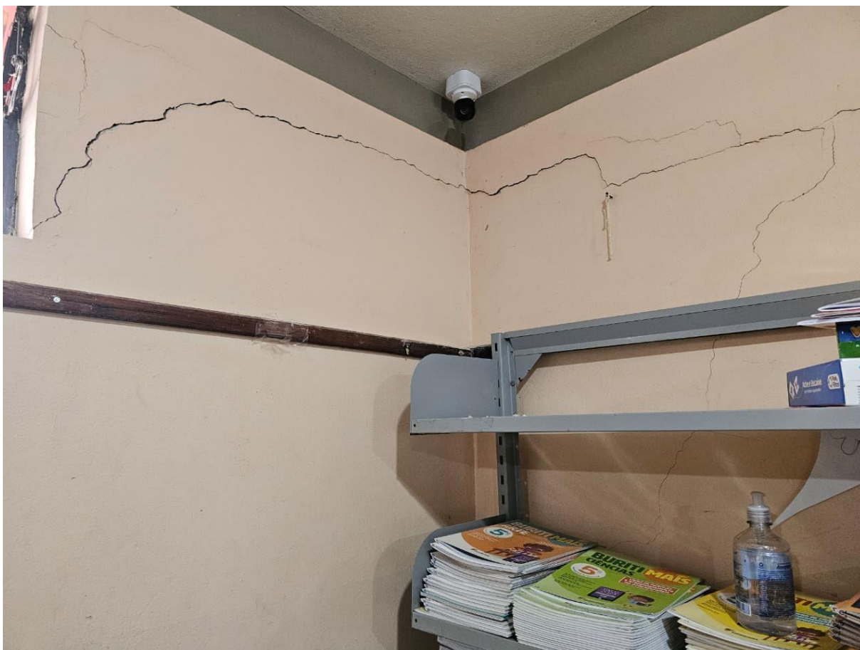
Foto 11: Paredes da sala de aula com trincas a serem reparadas
