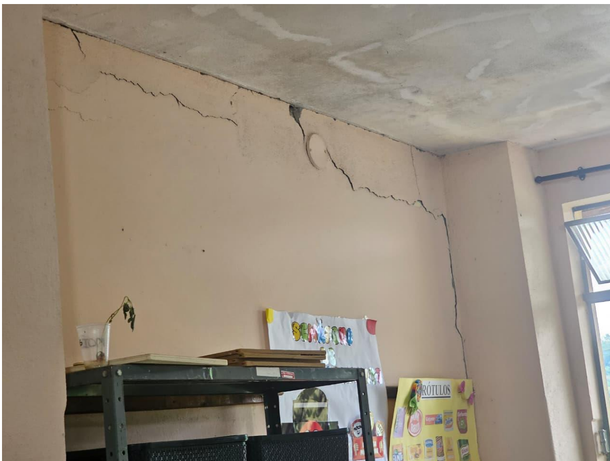
Foto 10: Paredes da sala de aula com trincas a serem reparadas
